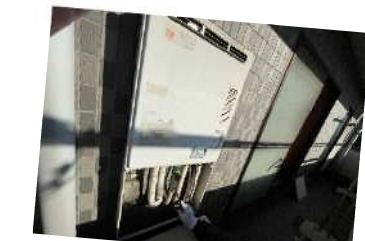
③給湯器内部に滞留した水も凍結するので給湯器内の水を排出！
