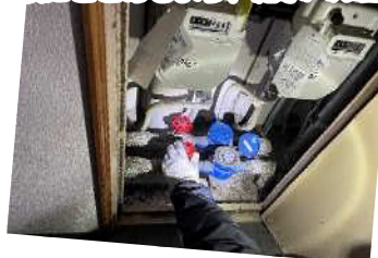
②万一配管が損傷しても水が噴き出す被害を最小限にとどめるよう、給水バルブOFF
